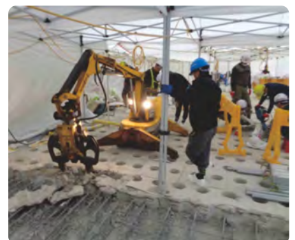
[아산 T-PJT MOCK-UP 공사 중 철거공사]
