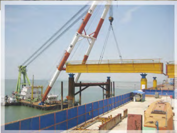
리마다크레인(450ton 해상크레인) 으로 OVERHEAD CRANE 인양·해체 2009. 10. 22.
