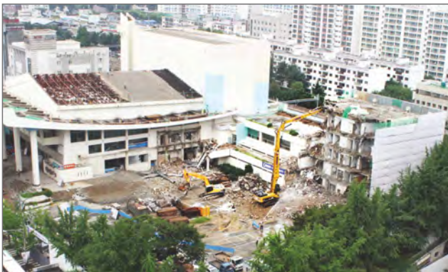
대구시민회관 리노베이션 공사 중 해체공사
