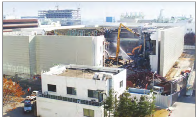
기흥 G1-PROJECT 골조 해체공사
