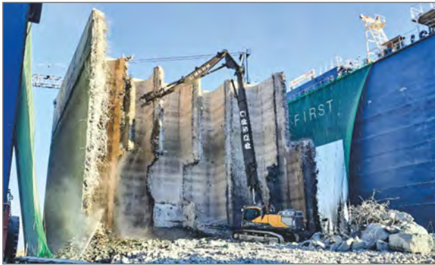
강릉안인화력 케이스 철거공사
